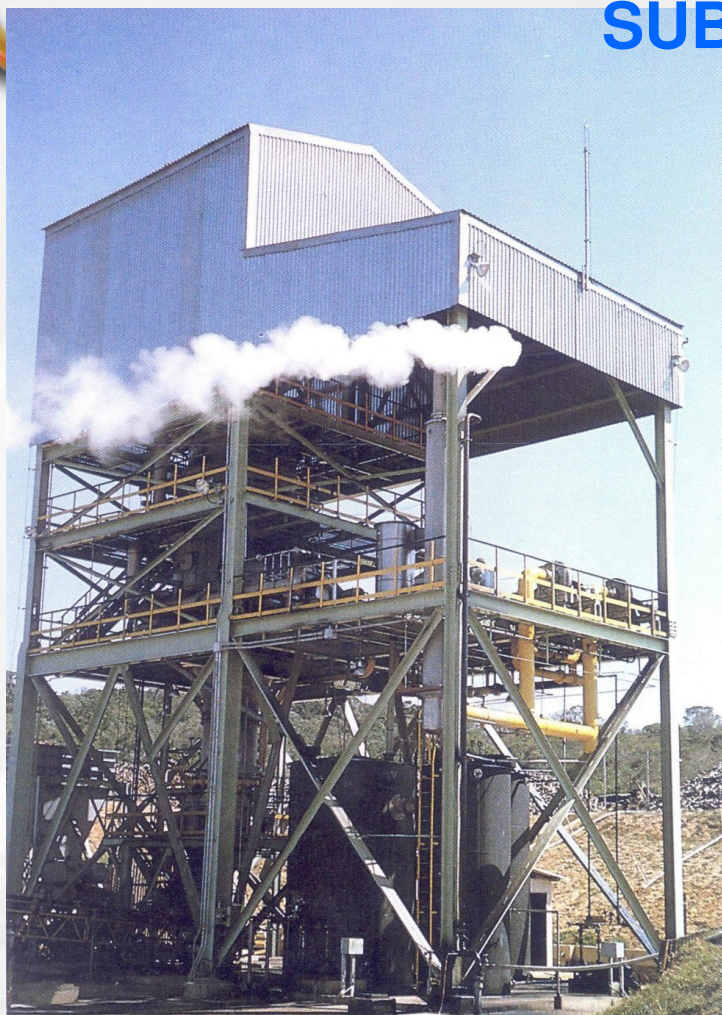
Retorta de Carbonização Contínua da Acesita
