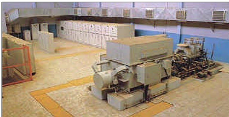
Casa de Força do Sistema de Cogeração de uma Usina de Açúcar
